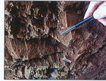
Test Pit no: TP50
